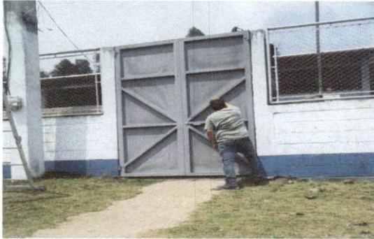
Foto1: Cambio de pórtón de malla por portón de estructura metálica a doble hoja con dos columnas de concreto armado.
