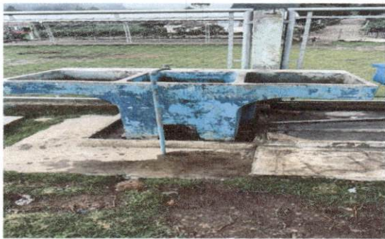
Foto 3: Sustitucion de pila de cemento de 2 lavaderos
