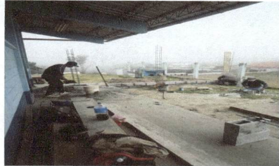
Foto 2: Reparacion de muro perimetral de malla vieja por malla nueva galvanizada 16.20 metros lineales con una altura de 1.50 metros.
