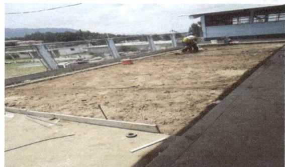
Foto 16.1 Reparacion de planchas de concreto de patio 55 metros cuadrados
